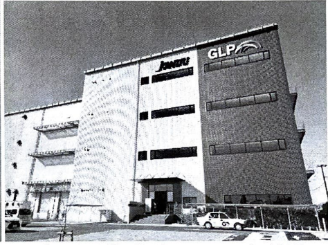
「関東 所沢物流センター」外観
